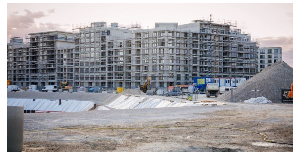
Im Sommer 2021 nimmt das neue Quartier langsam Gestalt an. Gut erkennbar ist die abwechslungsreiche Architektur der einzelnen Gebäude.
