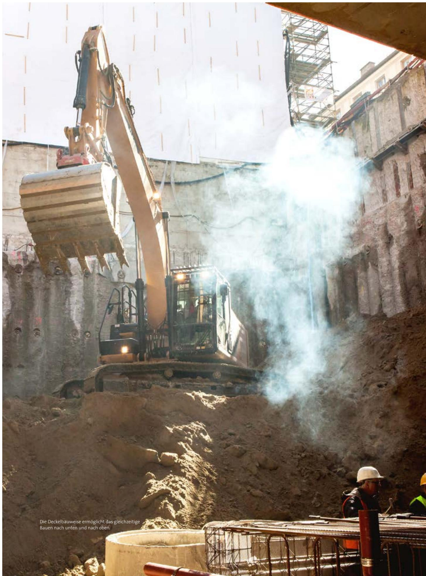
Die Deckelbauweise ermöglicht das gleichzeitige Bauen nach unten und nach oben.
