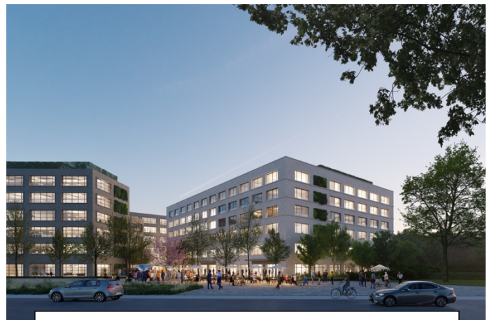
Blick von der Deelböge: Sysmex bezieht den westlich gelegenen Gebäudekomplex.
